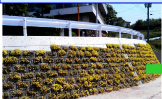
施工例(岡山県倉敷市内)
