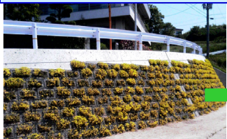
施工例(岡山県倉敷市内)
