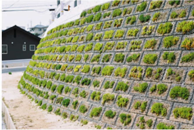
図2 本緑化ブロックを用いた施工例
